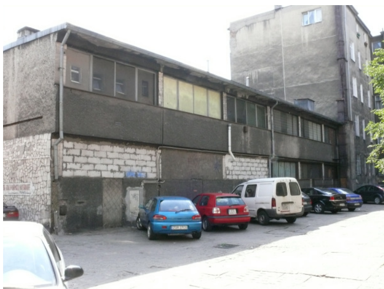
Fot. nr 2. Elewacja tylna (północna)
