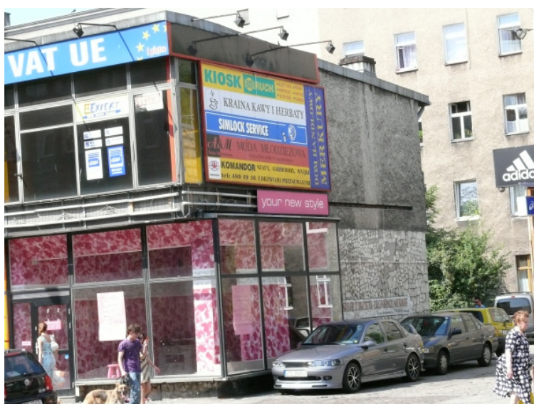
Fot. nr 3. Elewacja boczna (wschodnia)
